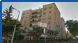
בהיבנר דירת גג, 4 חדר מושקעת! כניסה נפרדת! מעלית שבת וחניה מקורה
