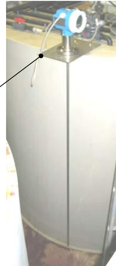
Fa. Würth, Neutralisationsbecken
