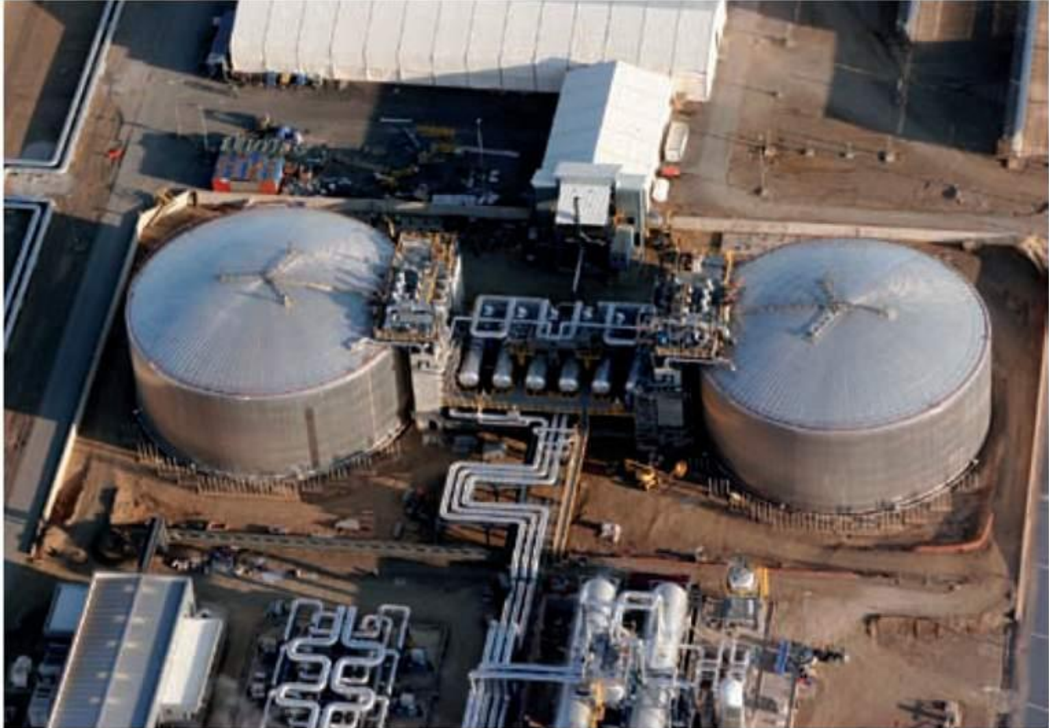
Foto 3. Andasol-1. Sistema de almacenamiento
