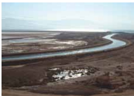
תעלת ההזנה המובילה מים מחלקו הצפוני של ים המלח לתעלות האידוי: מראה ביציאה מהחלק הצפוני.
